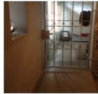
Grille de sécurité en fer-forgé
