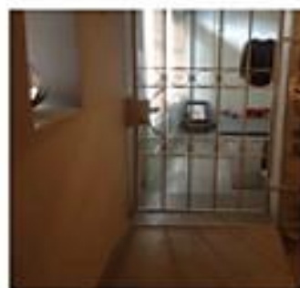
Grille de sécurité en fer-forgé
